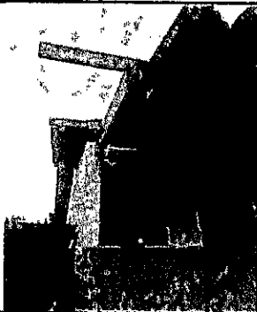
Foto 3: El viento levanto las laminas de las costaneras a tal punto de dejar casi espuesta una parte de una aula
